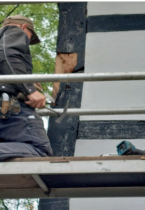
Die Arbeit hört nie auf. 2025 mussten einige Reparaturen an den Balken ausgeführt werden.
