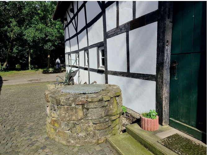
Bei den Sanierungsarbeiten wurde der Brunnenschacht entdeckt und mit Bruchsteinen aufgemauert.
