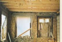
Bei der Restaurierung sollte der alte Zustand des Hauses erhalten bleiben. Sie stehen die Balken in der 1. Etage etwa für die Fachwerkwände. Auf die Ausmauerung zwischen den Geschossen verzichtete man allerdings bewusst für guten großzügiger transparenter Räumlichkeiten.
