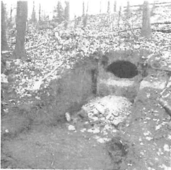
Bild 2a Teilweise geöffneter südlicher Stolleneingang
