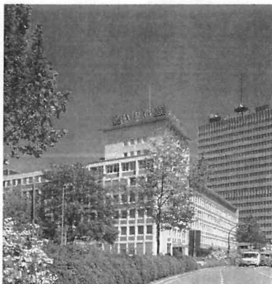
AEG-Gebäude an der Kruppstraße das Hochhaus rechts von der Postbank steht noch. (Foto aus der Festschrift 150 Jahre Industrie- und Handelskammer Essen-Mülheim-Oberhausen von 1990, S. 17)
