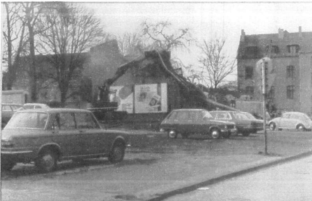
Abriss der Reste des Kindergartengebäudes
