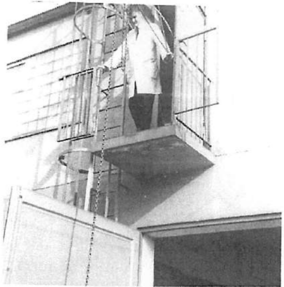
W. M.. beim Materialempfang an der Laufkatze
