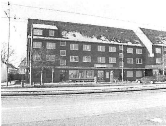
Frintroper Str. 403: Hier war die Post. (Foto Feb. 20013 A. K.)
