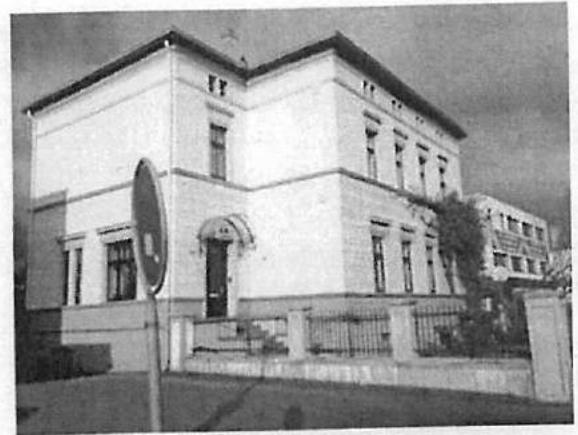
Hier wohnten Direktoren der Zeche Prosper: Bottrop, Essener Straße 237 (neben POCO-Einrichtungsmarkt), als Baudenkmal eingetragen am 29. November 1985 in die Denkmalliste der Stadt Bottrop. (Foto: Helmut Brus)
