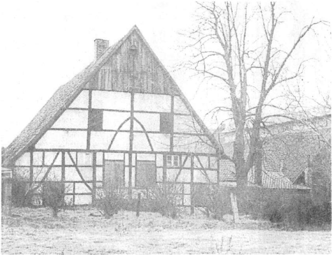
Der Gimkenhof am Düppenberg, 1963 abgerissen.
