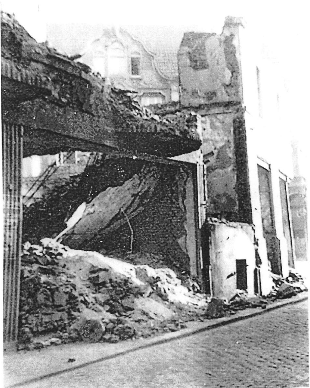
Borbecker Str. 140 / Weidkamp 2 – Aufnahme vom 4. 11. 1949 (Blick auf die Nixe aus Stuck am von-Leski-Haus)
