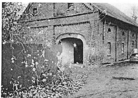
Ein imponierendes Stallgebäude, wohl um 1900 in dekorativer Ziegelbauweise errichtet, deutet darauf hin, dass der Hof Hunnenboke 9 im 20. Jahrhundert noch in Betrieb war. (Foto: Andreas Koerner, Nov. 2008)
