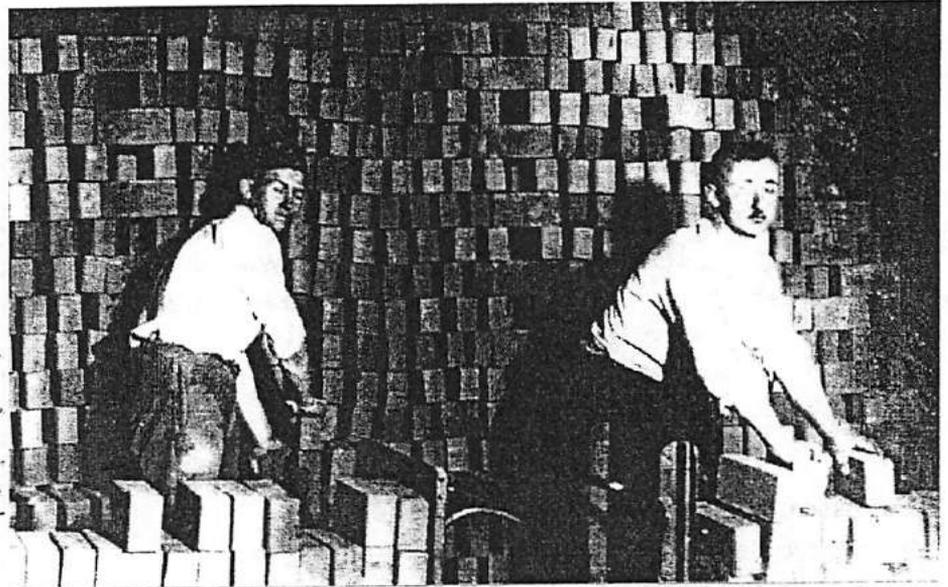
Ziegelarbeiter beim Einsetzen der getrockneten Ziegel in den Ringofen
